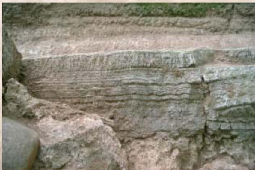
*Concrétions laissées par l'eau dans le canal de l'aqueduc. C'est par l'épaisseur de ce dépôt et les teintes des différentes strates qui le composent que la durée et la qualité de fonctionnement de l'ouvrage sont déterminées.*
