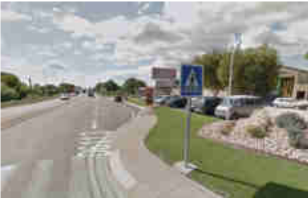
Bretelle d'accès à la cave coopérative
