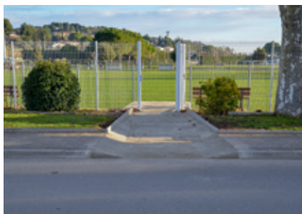
Aménagement d'accès handicapés, stade
