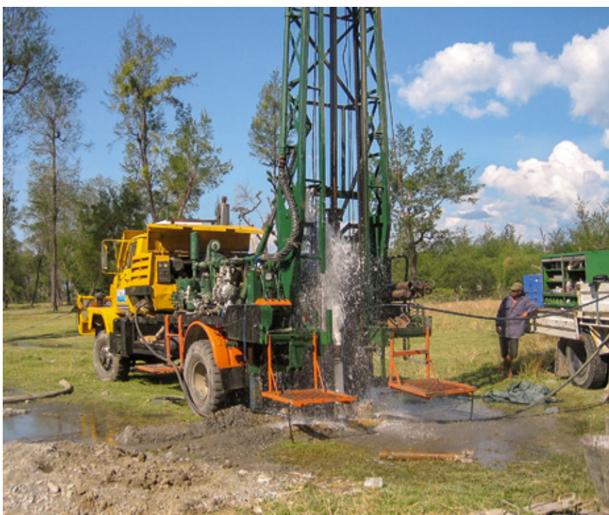
Renforcement captage d'eau
