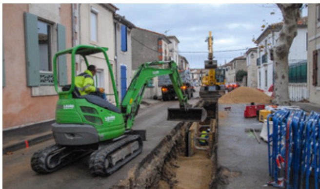
Réfection des réseaux d'adduction en eau potable et d'eaux usées
