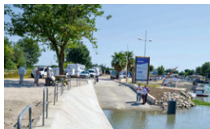
Rampe de mise à l'eau
