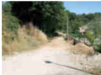
Accès sud raccordé au Chemin du Cros des Bars
