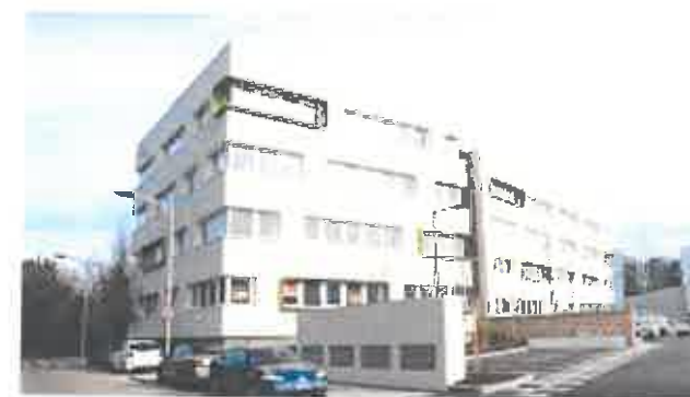
Locaux situés Parc Georges Besse, 184 Rue Maupas à Nîmes.
