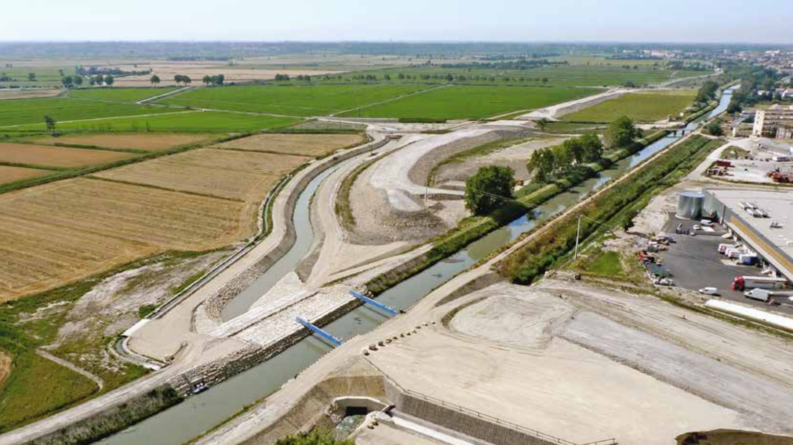
I Digue nord d'Arles et ressuyage de la plaine du Trébon
