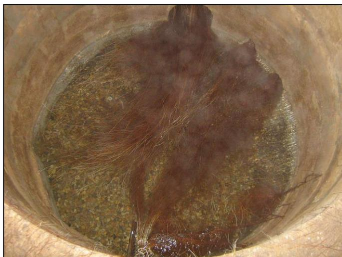
Figure 12 – Intérieur de la source Est de la Route de REDESSAN montrant l'arrivée d'une ou plusieurs galeries drainantes
