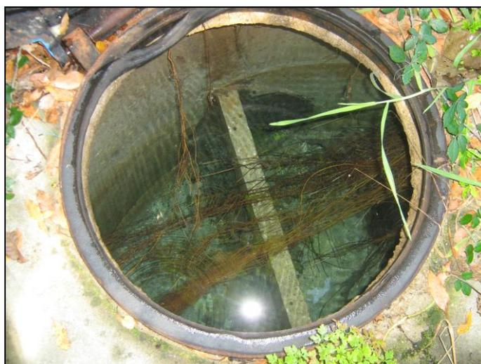
Figure 12 – Vue de l’intérieur d’un des capots Foug montrant le départ de la galerie de captage
