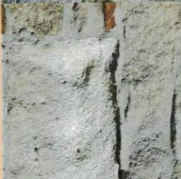
Délitement de la pierre dû au jointement au ciment artificiel
