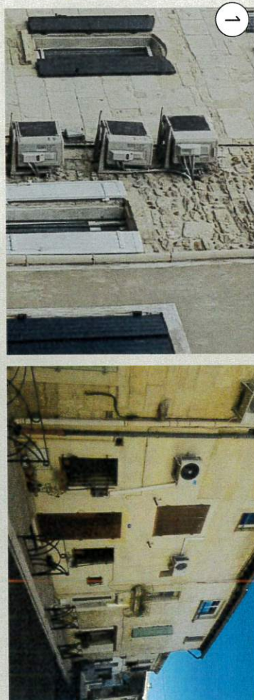
Exemple de bloc extérieur caché derrière un conduit 2 Caché derrière un conduit
