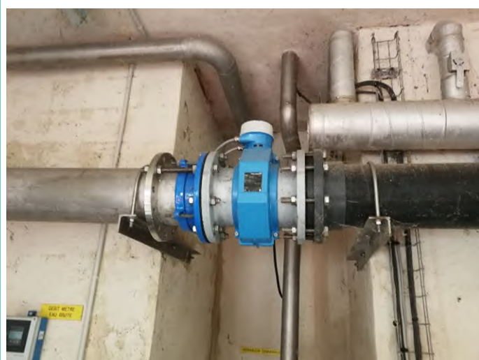
Débitmètre électromagnétique - mesure des eaux brutes à traiter (point réglementaire A3)
