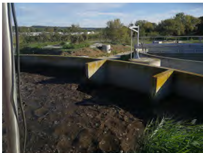
Surverse en sortie
