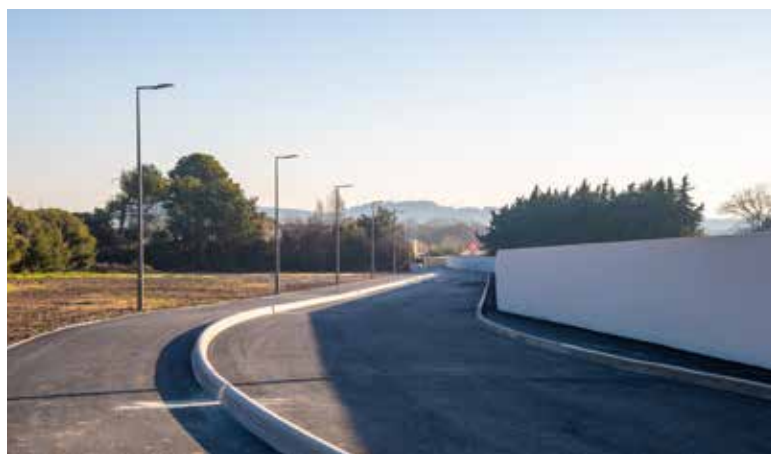
Réalisation d'une déviation à Jonquières-Saint-Vincent
