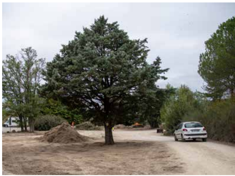
Ré-aménagement de l'aire de camping-car à Vallabrègues
