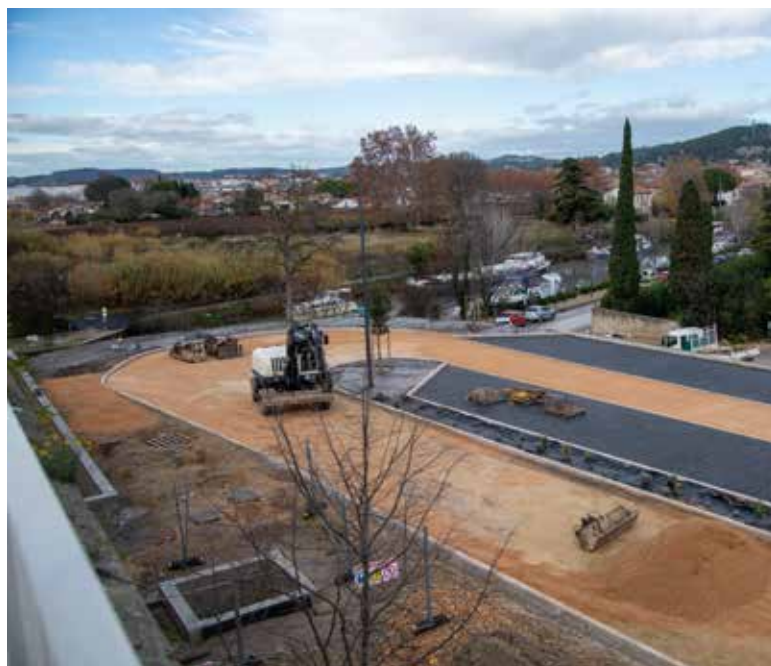
Avancement des travaux au Pôle Multimodal - Beaucaire
